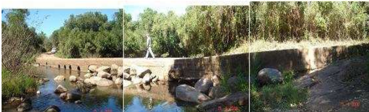
Foto nº 01 - Detalhe do volume de água existente em regime de escoamento normal do arroio e das margens do arroio, onde podemos observar o tipo de calha de escoamento e a vegetação das margens.
