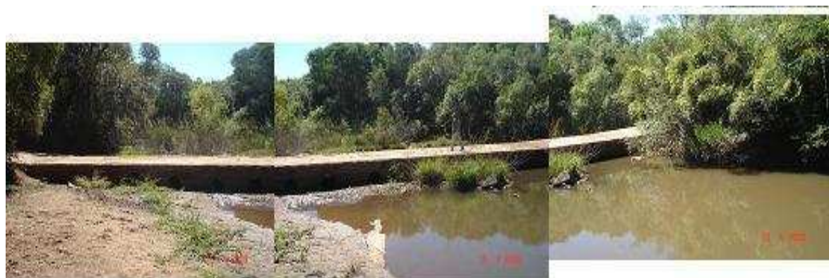
Foto nº 02 - Detalhe do volume de água existente em regime de escoamento normal do arroio e das margens do arroio, onde podemos observar o tipo de calha de escoamento e a vegetação das margens.
