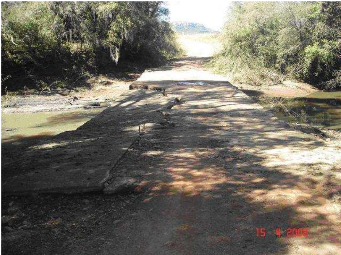
Foto nº 02 - Detalhe do volume de água existente em regime de escoamento normal do arroio e das margens do arroio, onde podemos observar o tipo de calha de escoamento e a vegetação das margens.
