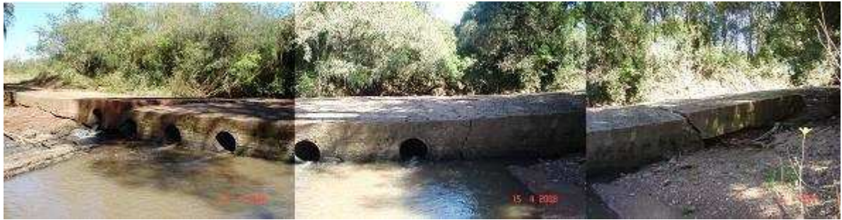
Foto nº 01 - Detalhe do volume de água existente em regime de escoamento normal do arroio e das margens do arroio, onde podemos observar o tipo de calha de escoamento e a vegetação das margens.
