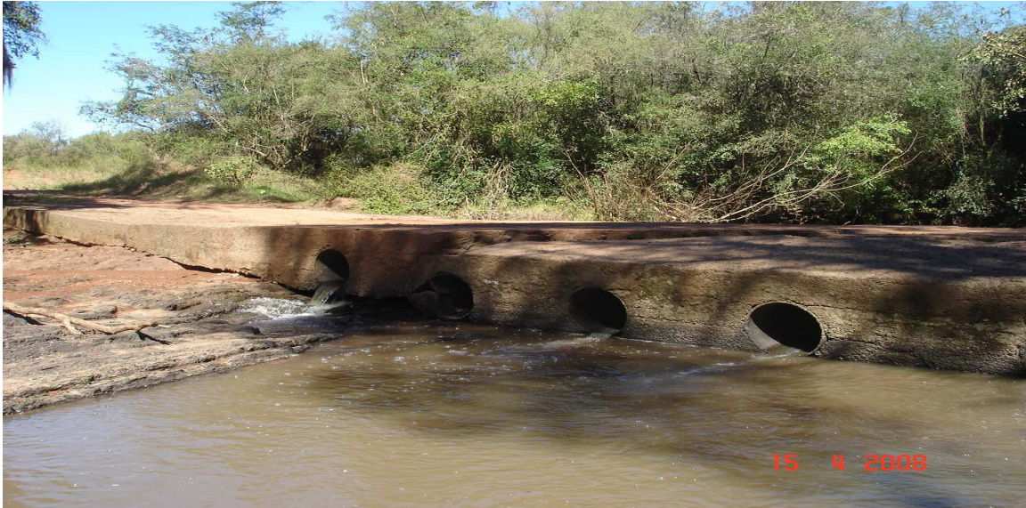
Foto nº 01 - Detalhe do volume de água existente em regime de escoamento normal do arroio e das margens do arroio, onde podemos observar o tipo de calha de escoamento e a vegetação das margens.
