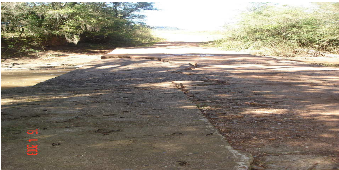
Foto nº 02 - Detalhe do volume de água existente em regime de escoamento normal do arroio e das margens do arroio, onde podemos observar o tipo de calha de escoamento e a vegetação das margens.
