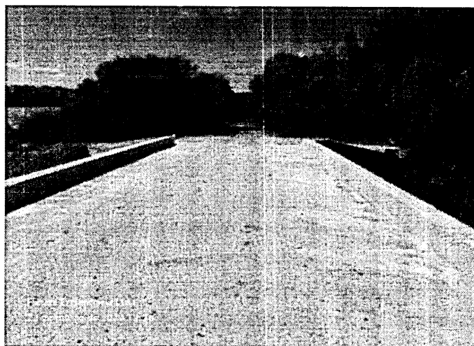
Foto 4: Vista da parte superior da ponte.
