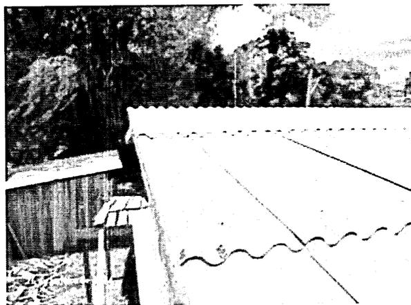
Fotos 1 e 2: Vista superior da ampliação da escola com laje de cobertura e telha plana já instalada.
