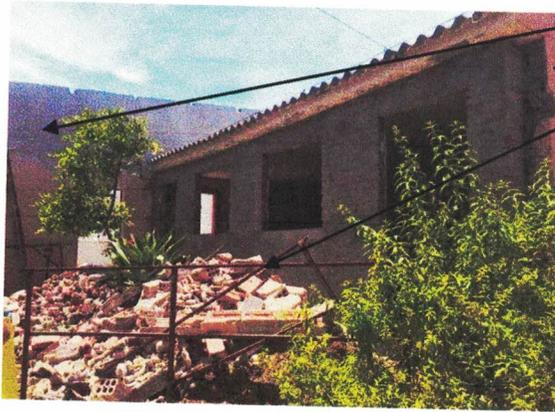
Concerto do alicerce e paredes: tijolo, cal, cimento, ferro, brita, areia, argamassa, malha de ferro
